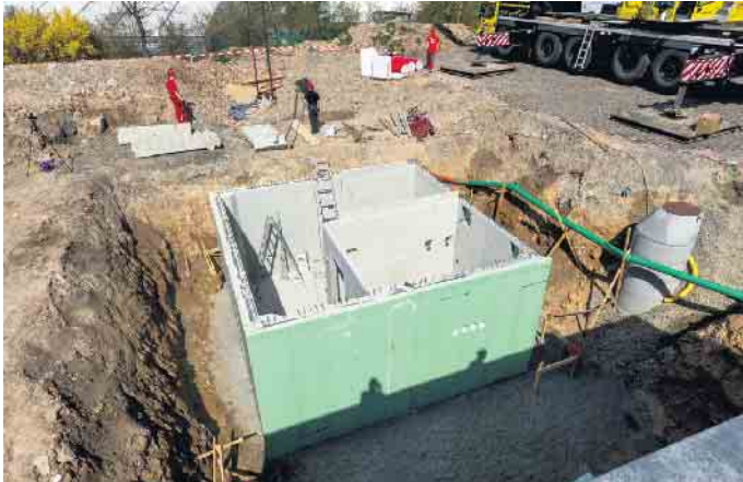
6,50 mal 6,50 Meter Baugrube reichen für einen kompakten Teilkeller meist schon aus. Foto: GÜF/Glatthaar Keller
