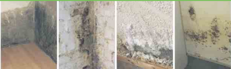
Defekte Horizontalsperre Querdurchfeuchtung Ausblühungen Schimmelbefall
