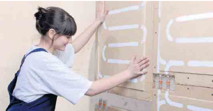
Trockenbau-Lehmputzplatten lassen sich einfach verschrauben oder verkleben. Das aufwendige Anmischen und manuelle Aufbringen des Putzes auf Wand- oder Deckenflächen kann man sich so ersparen. Foto: DJD/Naturbo
