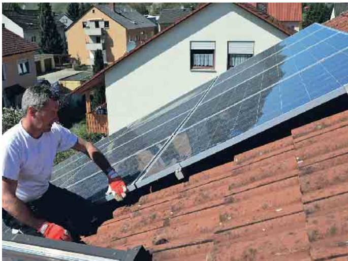
Der qualifizierte Dachdecker prüft die Befestigungen der Solarmodule und begutachtet die Unterkonstruktion im Rahmen des DachChecks. Foto: HF Redaktion/akz-o
