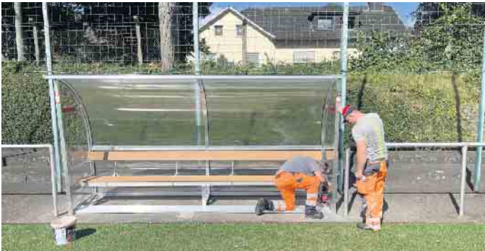
Mitarbeiter des Bauhof Eitorf bei der Montage der Spielerunterstände
