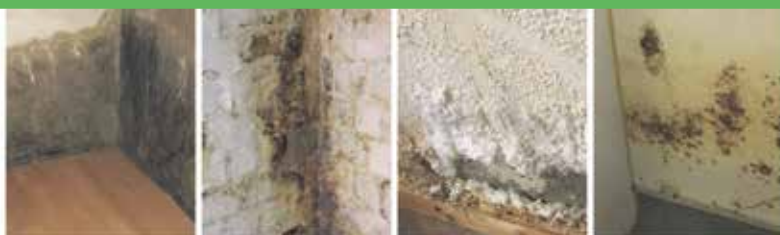
Defekte Horizontalsperre
