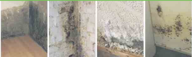
Defekte Horizontalsperre Querdurchfeuchtung Ausblühungen Schimmelbefall
