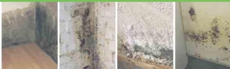
Defekte Horizontalsperre
