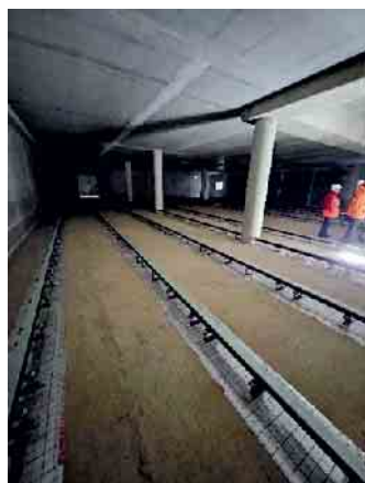
Auch das Stadtarchiv zieht um. Hier sieht man die Schienen für die Archivschränke für die Dokumente von über 700 Jahren Stadtgeschichte.
