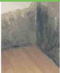
Defekte Horizontalsperre
