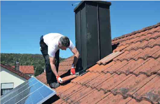
Anschlüsse an Dachdurchdringungen werden beim DachCheck begutachtet. Foto: HF Redaktion/akz—o
