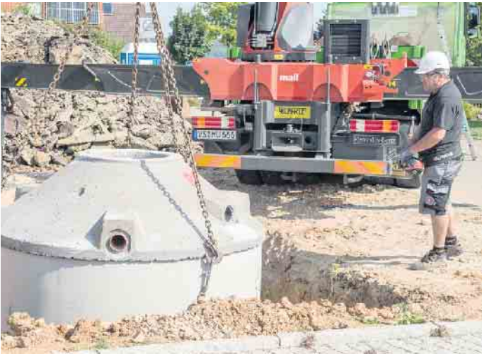
Eine Betonzisterne wird per Kran in die vorbereitete Gartengrube eingelassen. Foto: DJD/Mall
