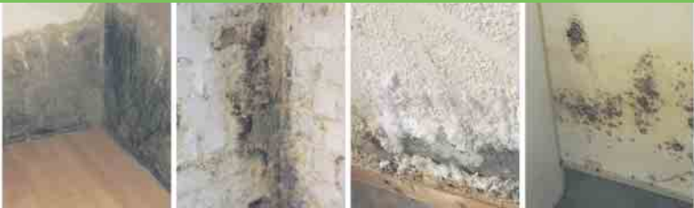
Defekte Horizontalsperre Querdurchfeuchtung Ausblühungen Schimmelbefall
