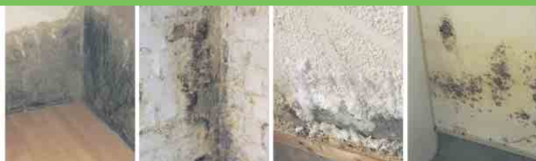
Defekte Horizontalsperre
