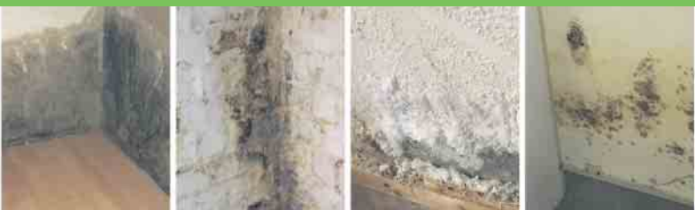
Defekte Horizontalsperre Querdurchfeuchtung Ausblühungen Schimmelbefall
