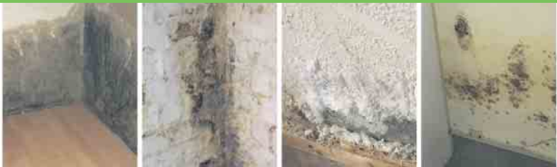
Defekte Horizontalsperre Querdurchfeuchtung Ausblühungen Schimmelbefall
