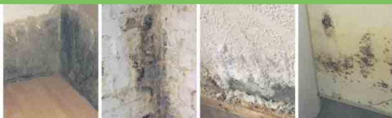
Defekte Horizontalsperre
