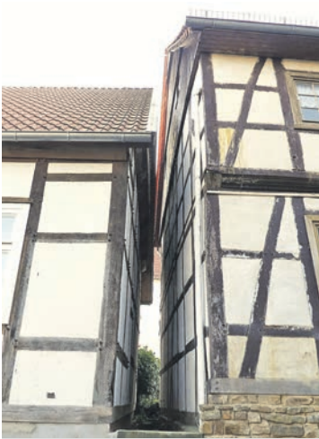
Der Abstand zwischen den Giebeln der Fachwerkhäuser am Kirchplatz in Lintorf hier weniger als 0,5 m. Im Brandfall würde das Feuer überspringen auf das jeweils andere Bauwerk.
