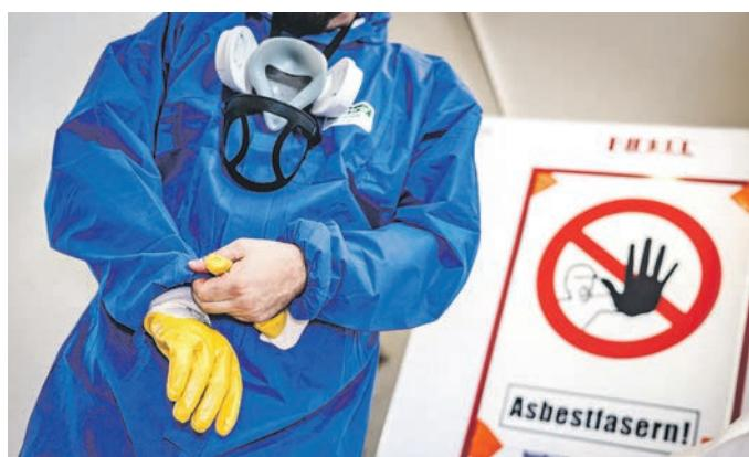
So läuft Asbest-Sanierung: Overall, Atemschutzmaske, Handschuhe und dazu noch eine Schutzbrille. „Komplett-Schutz ist ein Muss“, sagt die Bau-Gewerkschaft. Foto: IG BAU | Alireza Khalili
