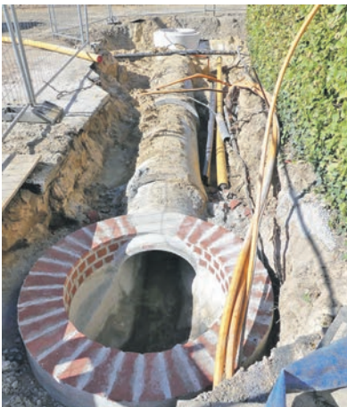
Die Anlieger der Bahnhofstraße in Wittlage sind aktuell Zeuge einer Tiefbaumaßnahme, bei der der Regenkanal mit einem größeren Rohrquerschnitt erweitert wird.
