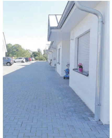
Ein langes Reihenhauses – sauber gepflastert bis an die Hauskante und für die Einstellplätze, das Niederschlagswasser läuft vollständig in den Regenkanal ein, Versickern auf dem Grundstück: Fehlzanzeige.
