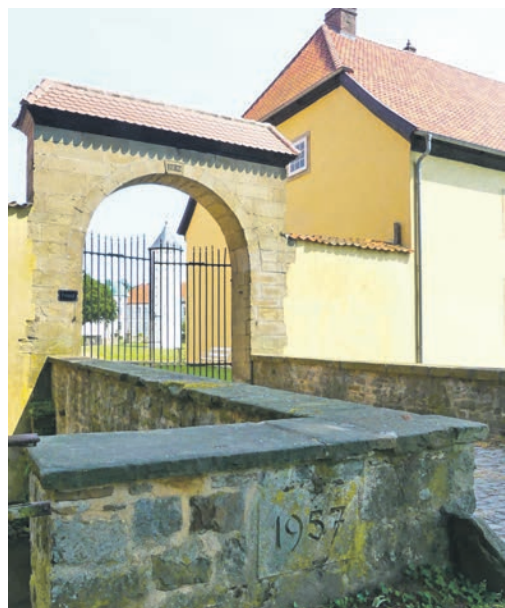
Die aus Bruchsteinen gemauerte Brücke hat zwei Röhren im Schlossgraben und das Jahr der Erbauung oder der Erneuerung wird mit der Jahreszahl 1957 angegeben, im Torbogen die Jahreszahl 1732.
