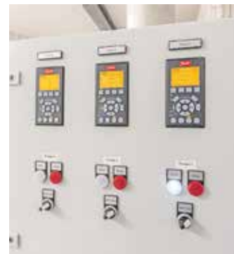
Die Pumpen werden elektronisch gesteuert. Foto: Wasserverband Wittlage/Jochen Thrien-Franck
