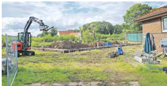
In Hunteburg wird an der Tennisanlage ein Padel-Platz gebaut.
