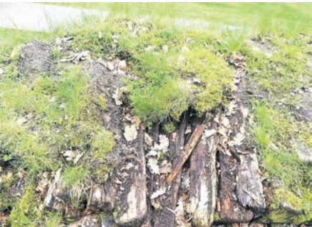
Die an der Oberfläche sichtbaren Rundhölzer der halbrunden Einfassung zeigen, dass das Eichenholz im Zeitraum von knapp 15 Jahren morsch ist.
