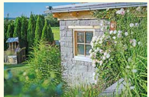
Mal was anderes als das klassische Holz-Gartenhaus: eine kleine Hütte aus Betonsteinen. Foto: DJD/ braun-steine/Benedikt Walther
