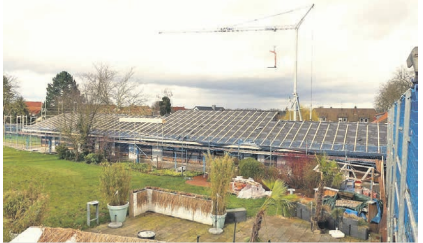
Der Umkleide- und Kassen-Trakt erhält ein Pultdach mit großer Dachfläche zur Südseite, optimal, um die Sonnenenergie zu nutzen.
