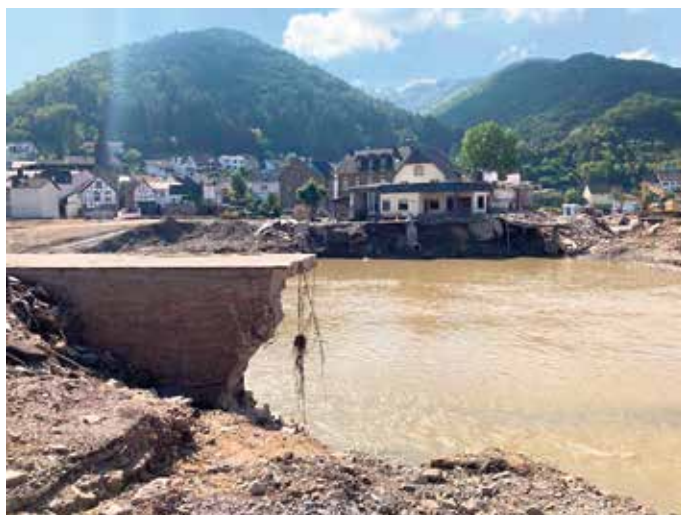
Ein Bild sagt mehr als tausend Worte: Zerstörungen und über die Ufer getretener Fluss Ahr 2021. Fotos: Horst Kanbach und Frank Kanbach
