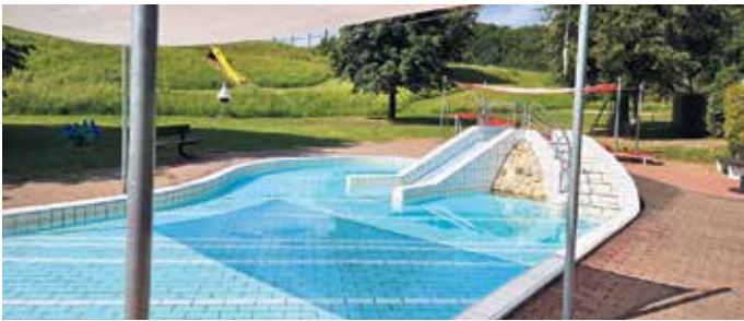
Der Kleinkindbereich im Freibad in Neuenheerse. Im Hintergrund die Hangrutsche und der Wasserspielplatz.
