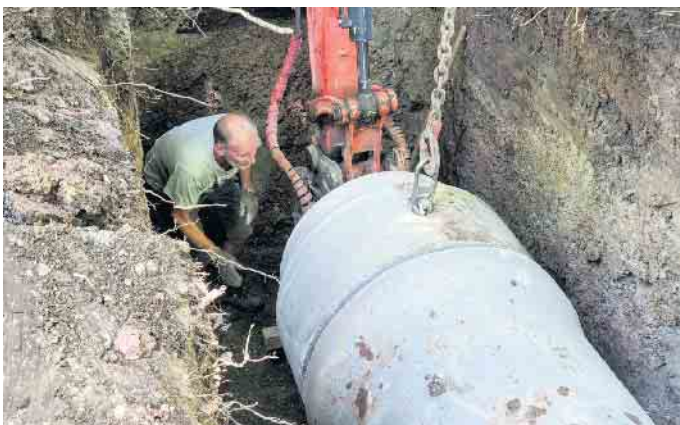
Insgesamt wurden ein Kilometer Rohrleitung verlegt.
