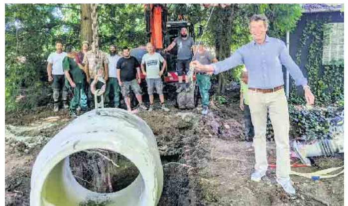
Marcus Graf von Oeynhausen-Sierstorpff feiert mit Tiefbauarbeitern Kanaltaufe.
