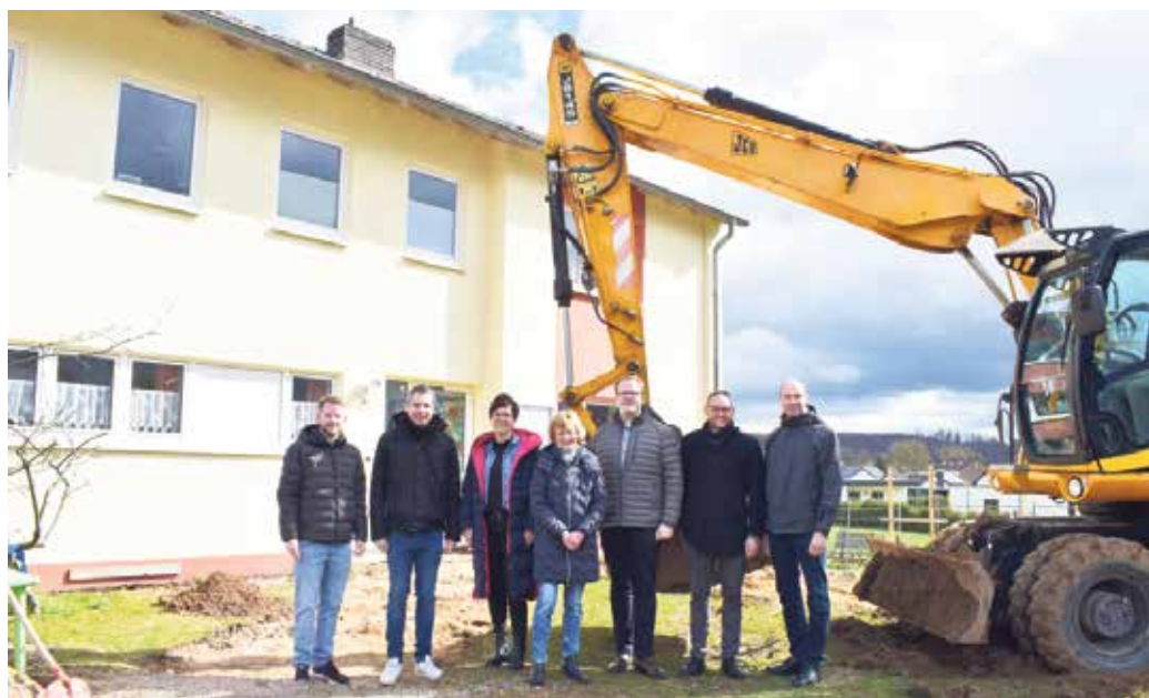
Von links: Marian Claes (Architekt), Johannes Gödde (Hochbauamt), Dagmar Hillen (Leiterin Hochbauamt), Birgit Altmann (Kita-Leitung), Bürgermeister Tobias Tölle, Baudezernent Florian Greger, Bildungsdezernent Uwe Damer auf der Baustelle vor der Kita.
