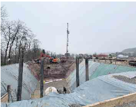
Baugrube für den in der Auslaufstrecke befindlichen MID-Schacht.
