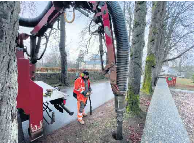
Mit einem Saugbagger wurde die verdichtete Erde im Wurzelbereich abgesaugt und durch durchlässiges Substrat ersetzt. © Gemeinde Dahlem
