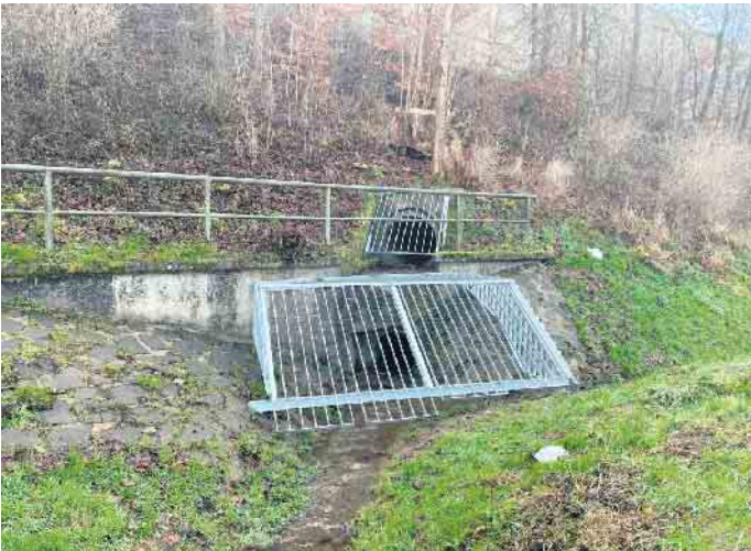
Damit zukünftig das Wasser hinter dem Netto-Markt ungehindert abfließen kann, hat der Landesbetrieb Straßenbau NRW Schutzgitter vor die Durchlässe der B 51 angebracht. © Gemeinde Dahlem
