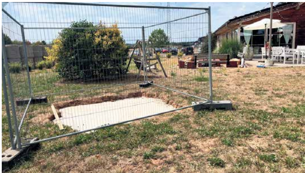
Bis zum Jahresende sollen aus derzeit noch rätselhaften Baustellen im ganzen Kreisgebiet neue Lieblingsplätze werden: An 47 Standorten entstehen gerade Fotopoints. Foto: Kreis Euskirchen
