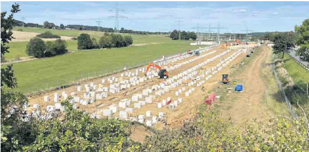
Auf die Punktfundamente werden in den nächsten Wochen die Batterie-Container aufgesetzt. © Gemeinde Dahlem
