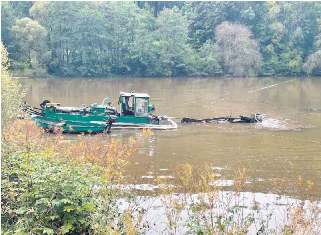
Mit dem schwimmenden Spezialgerät werden die Sedimente am Seeboden gelöst, angesaugt und durch die Leitungsrohre zum Parkplatz gepumpt. © Gemeinde Dahlem
