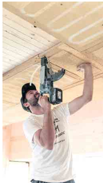
Trockenbau-Lehmputzplatten lassen sich einfach verschrauben oder verkleben. Das aufwendige Anmischen und manuelle Aufbringen des Putzes auf Wand- oder Deckenflächen kann man sich so ersparen. Foto: DJD/Naturbo
