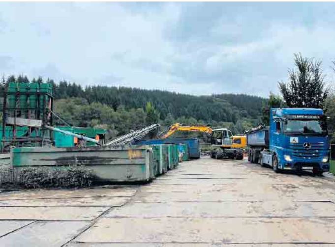
Auf dem Parkplatz wird mit großem technischen Aufwand das Sedimentmaterial entwässert, in 3 verschiedene Fraktionen getrennt und abgefahren. © Gemeinde Dahlem
