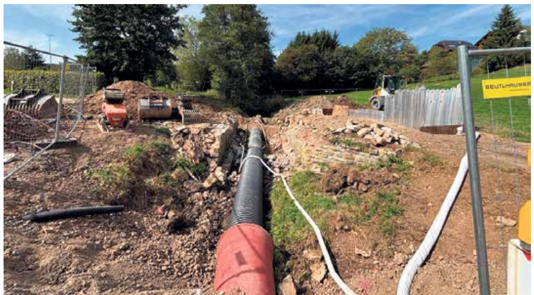
In Schmidtheim wird derzeit an einer Brücke über die Urft gearbeitet. © Gemeinde Dahlem
