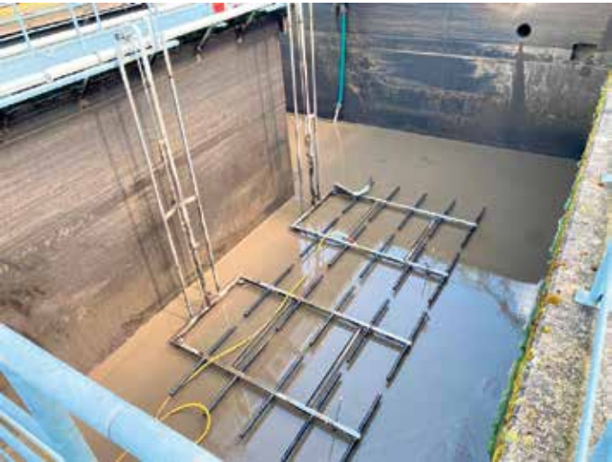
Blicke in das geleerte Belebungsbecken mit der Lüftungsanlage. © Gemeinde Dahlem
