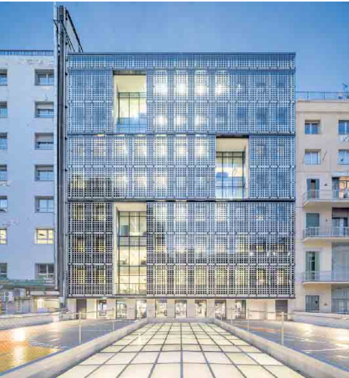
Gut für Klimabilanz und Energieausbeute: Eine vorgehängte BIPV-Lösung an der Fassade einer Gewerbeimmobilie. Copyright: AGC Glass Europe
