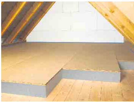
Eine professionelle Wärmedämmung verhindert, dass über den Dachboden kostspielige Heizenergie ungenutzt entweicht. Foto: djd/Brillux Zuhause
