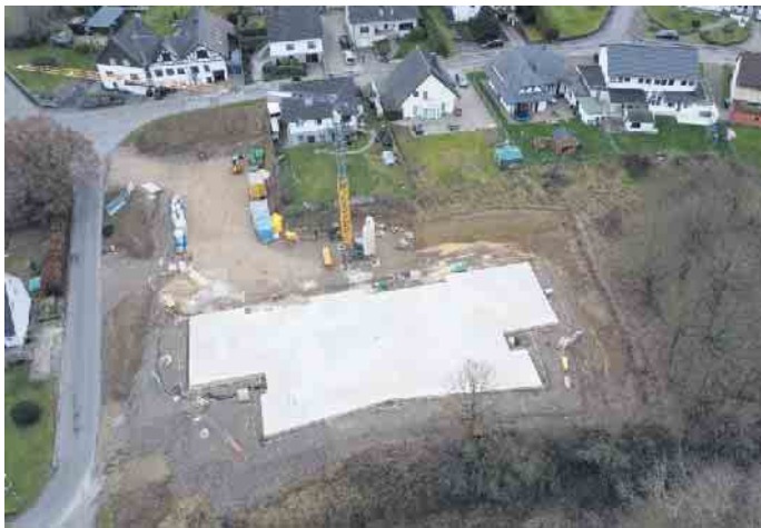
Die Bodenplatte des neuen Kita-Gebäudes ist fertiggestellt. © Bohnen
