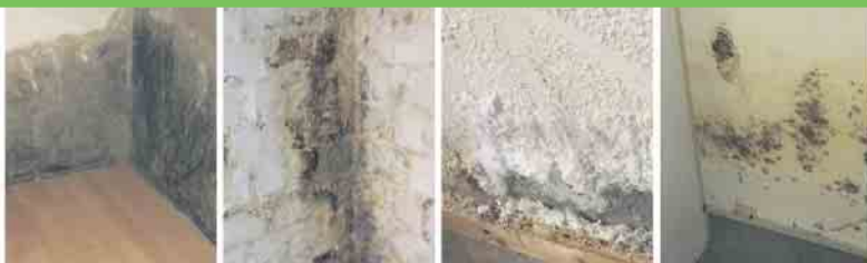
Defekte Horizontalsperre
