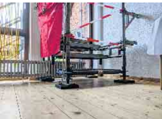
Ein Fenster fungiert im Notfall als Ausgang zur übergangsweisen Fluchttreppe.
