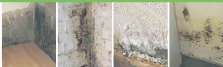
Defekte Horizontalsperre
