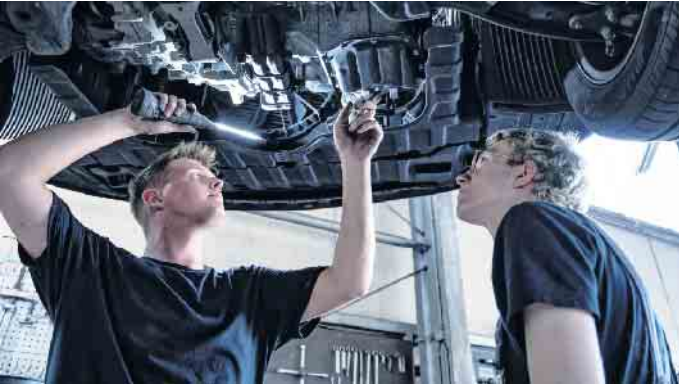
Beim Klimaanlage-Check prüft der Kfz-Mechaniker alle Teile der Anlage und ihre Funktionen. Foto: DJD/Kfzgewerbe/Heike Wippermann
