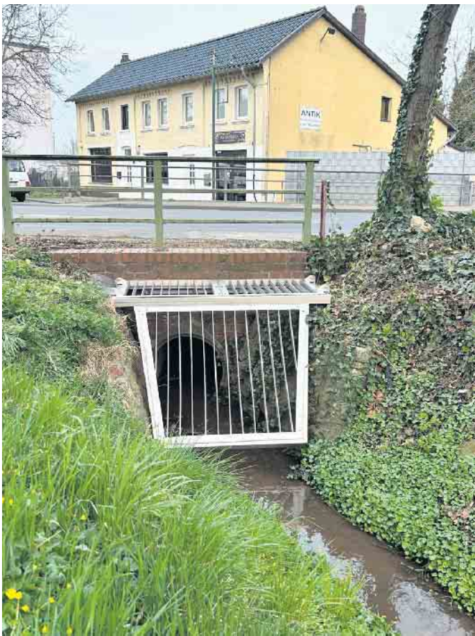
Der neue räumliche Rechen am Umbach in Sinzenich entspricht den aktuellen technischen Standards für ein solches Bauwerk und soll eine Verklausung der Rohrleitung bei starker Wasserführung verhindern. Foto: Stadt Zülpich / Torsten Beulen
