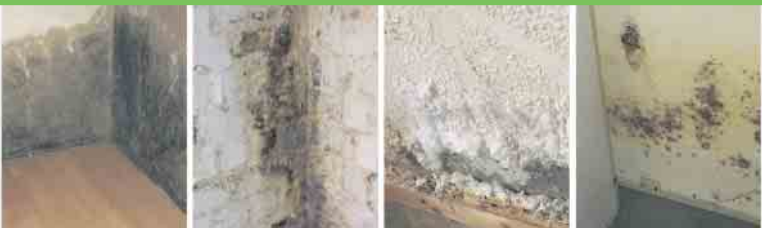
Defekte Horizontalsperre Querdurchfeuchtung Ausblühungen Schimmelbefall
