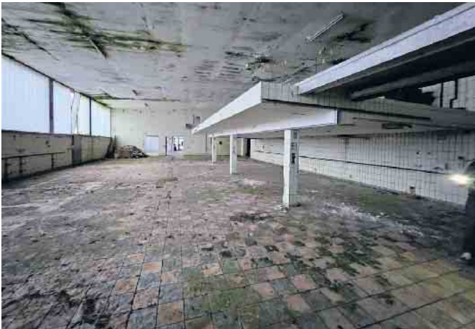
Ein Blick ins Innere - Beton über Beton.
