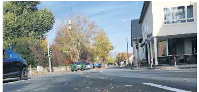
Die Gehwege und Verkehrsflächen der Nieheimer Straße werden von der Sparkasse bis zum Bredenweg erneuert.
