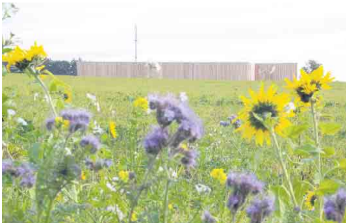
Der neue Hochbehälter am Brakeler Galgenberg sieht mit seiner Holzverschalung wie eine große Flachdach-Scheune aus.
