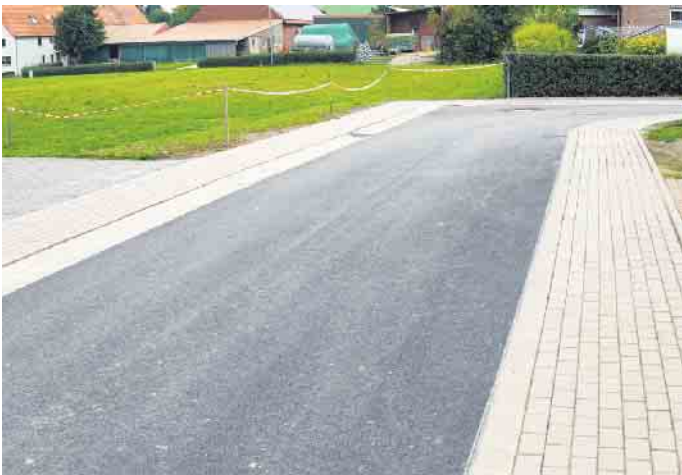
Die Bauarbeiten begannen am 24. Juni 2025 und konnten nach gut zwei Monaten Bauzeit abgeschlossen werden.
